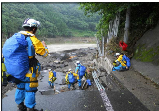
搜索現場への移動状況
