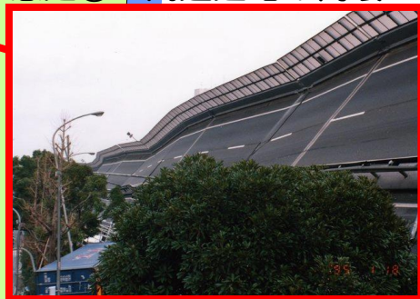
想定②～高速道路の倒壊
